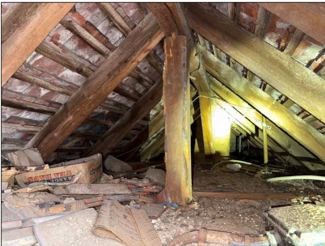
Abb. 5: Dachboden im verlassenen Mehrfamilienhaus (28.08.2025).
