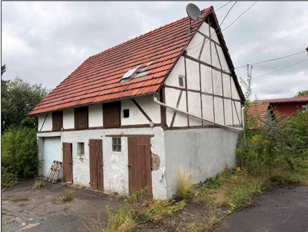
Abb. 4: Stallgebäude, Blick vom Nordrand des Streuobstbestandes nach Nordosten (28.08.2025).
