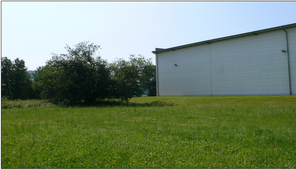
Foto 4: Ansicht der Gebäude-Anbaufläche aus N nach S mit der Baumweide und Rasen, Fettwiese 10.07.13
