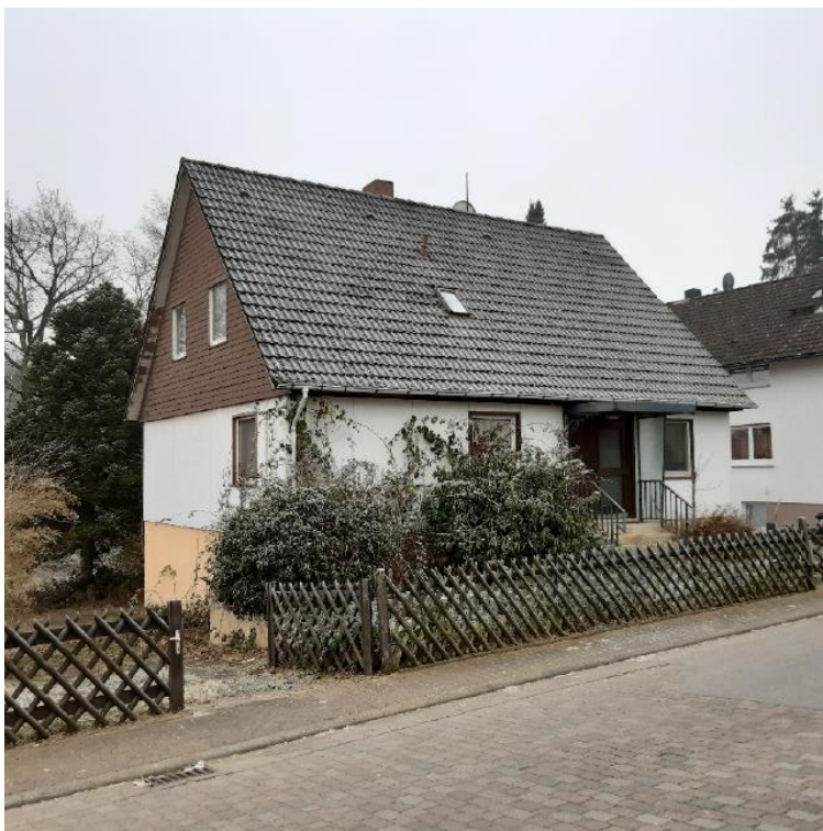
Foto 1: Aktuelle Bebauung auf dem Plangrundstück (Quelle: Architekt Thomas Trautmann, 2020)
