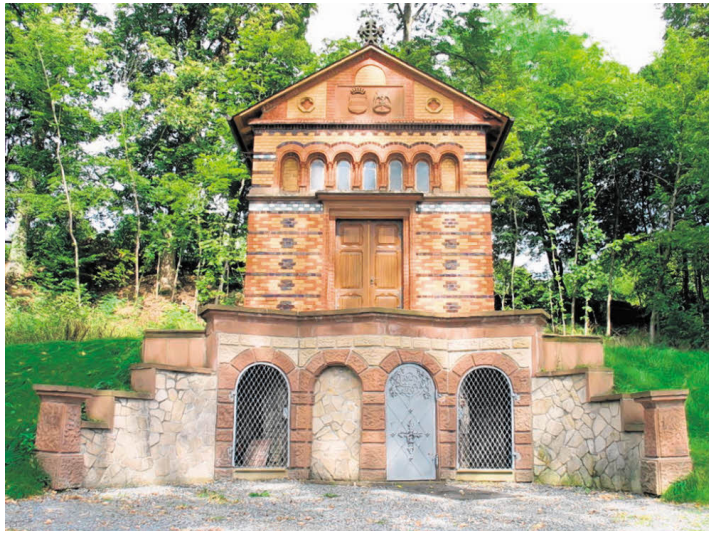
DER SAROLTAKAPELLE drohte der Verfall – bis sich 2000 der Verein „Crumbacher Denk-Mal!“ ihrer annahm. Foto: Gemeinde
