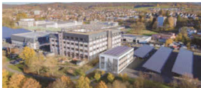
Am „Haus der Energie“ entsteht mit dem „Haus der Wirtschaft“ ein neues Gebäude nach KfW-Effizienzstandard 40. Foto: EGO
