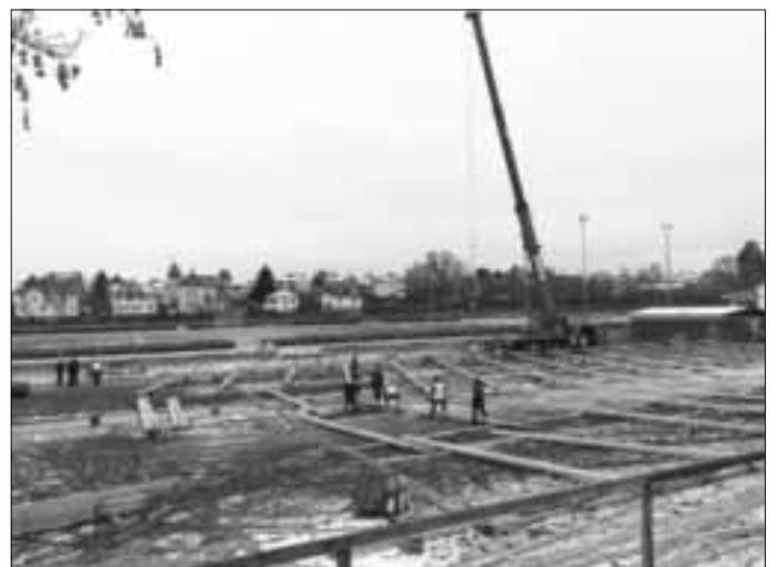
*So entsteht ein Impfzentrum: Auf dem Wiesenmarkt-Gelände in Erbach ist heute Mittag ein Autokran vorgefahren, um die tragenden Elemente der Messehalle anzuheben.*
