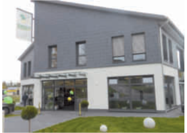
Die neue Fassade am Haupteingang.
