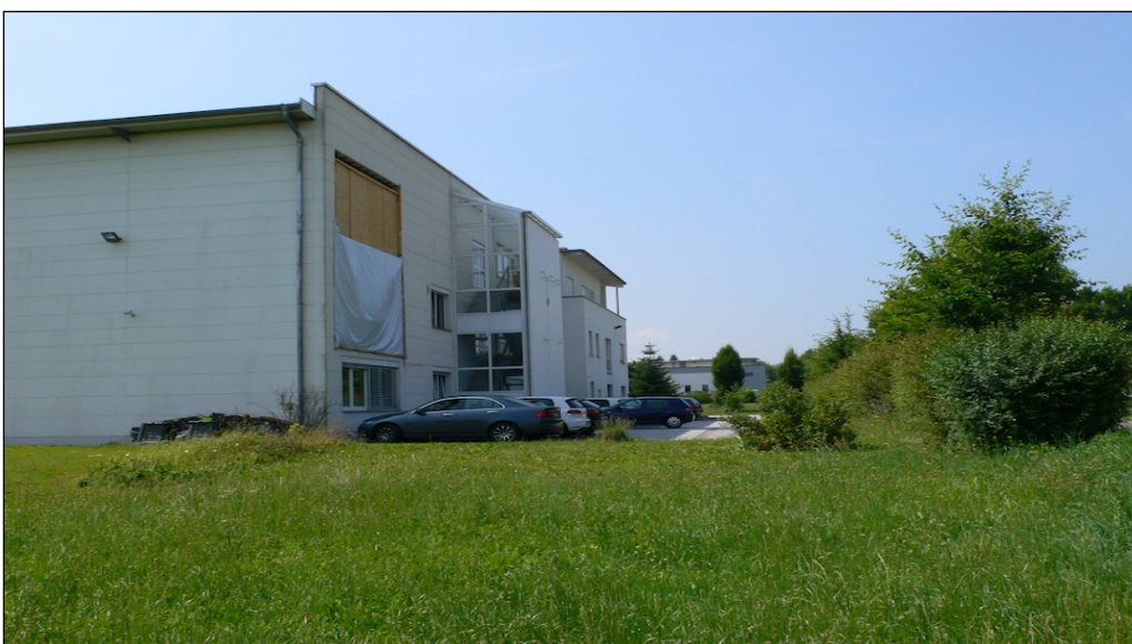
Foto 3: Vor dem Nordrand des Gebäudes mit Ansicht von NO mit der Ostwand und davor Rasen, Fettwiese 10.07.13
